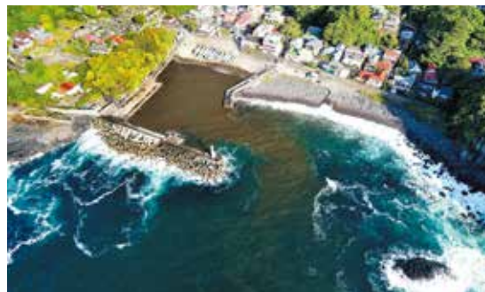
事業地からの土砂の流出
