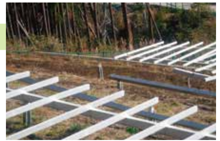
パネルが片付けられ、架台が未設置の現状
